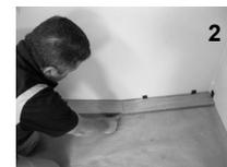
Disposez la première rangée le long du mur. Notez qu'un espace d'expansion/contraction minimum de 1/2 po (13 mm) doit être prévu le long du mur. Cette distance doit également être prévue pour toutes les colonnes, tuyaux de chauffage, encadrement de porte, etc.
