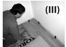
En continuant la rangée #2 avec un plein morceau, placez la languette du côté long dans la rainure du morceau de la première rangée (photo IV), rapprochant les joints courts des deux planches, jusqu'à ce qu'ils soient approximativement à 1/4 de pouce (6mm). Cliquez maintenant la planche en place sur le côté long. Pour le bord court, utiliser le bloc de Tapement Uniclic® et frapper à l'aide de plusieurs petits coups jusqu'à ce que les planches se cliquent ensemble complètement.
