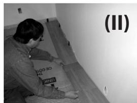
Le morceau coupé de la première rangée devient la première planche commençant la rangée #2, le bord coupé est installé face au mur, avec la cale de séparation en place. Ce morceau est maintenant prêt à être cliqué à la planche #1 de la première rangée. Les morceaux coupés devraient être de 8po (20cm) minimum de longueur (III).
