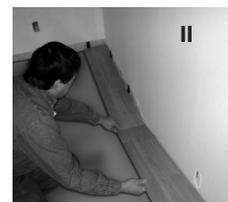
Le morceau coupé de la première rangée devient la première planche commençant la rangée #2, le bord coupé est installé face au mur, avec la cale de séparation en place. Ce morceau est maintenant prêt à être cliqué à la planche #1 de la première rangée. Les morceaux coupés devraient être de 8 po (20cm) minimum de longueur (III).
