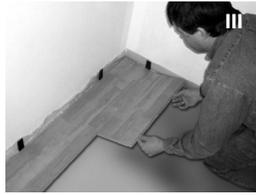
Le morceau coupé de la première rangée devient la première planche commençant la deuxième rangée, le bord coupé est installé face au mur, avec la cale d'expansion en place. Ce morceau est maintenant prêt à être cliqué à la première planche de la première rangée. Les morceaux coupés devraient être de 8 po (20 cm) minimum de longueur (III).
