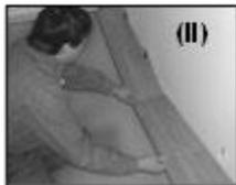
Le morceau coupé de la première rangée devient la première planche commençant une autre rangée. Installez le bord coupé face au mur, avec la cale d'espacement en place. Relevez maintenant ce morceau à angle et encliquetez-le dans la première planche de la première rangée.
