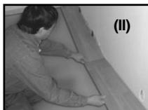
Notez qu'un espace d'expansion et de contraction de 13 mm (1/2 po) doit être prévu le long du mur, de même qu'autour des colonnes, tuyaux de chauffage, encadrements de porte, etc.
